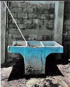
Foto 5: La pila esta en malas condiciones necesita ser reemplazada.
