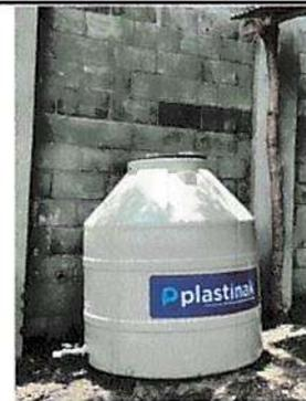
Foto 6: El depósito de agua necesita ser reemplazado e implementar una base fija de metal con columnas de concreto donde colocarlo.
