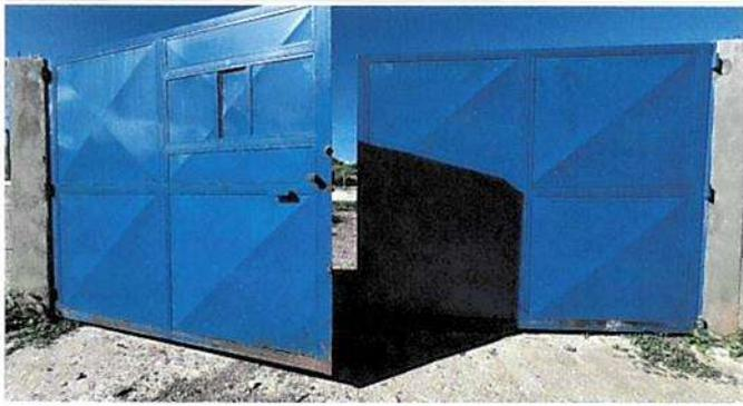
Foto 1: El portón de la entrada principal presenta daños en la chapa y en la lamina.
